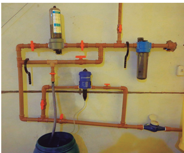
Figura 7: Dosificador instalado en la red hidráulica para medicación vía agua de bebida.
